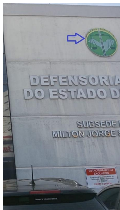
Imagem 8 - Lote 3 - itens 8 e 9 - Exemplo de brasão que será removido e substituído por um novo.
