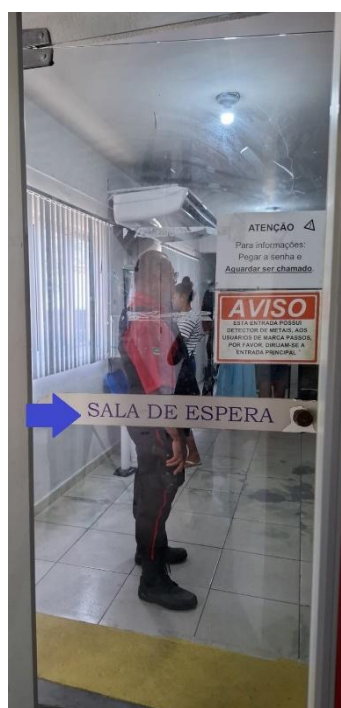
Imagem 6 - Lote 3 - item 3 e 5 - porta onde será colocada a logo da defensoria, retirado o adesivo "sala de espera" e colocado o novo.
